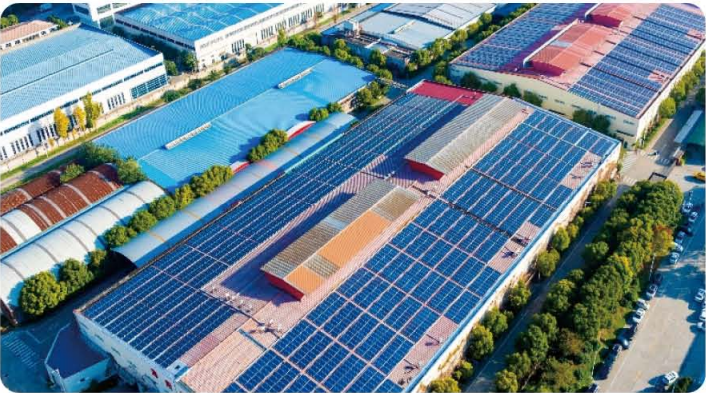
屋顶分布式光伏电站
