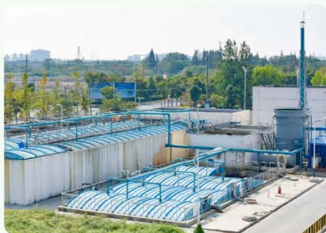
海阳锦纶污水处理设施
